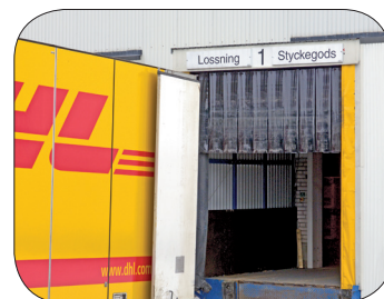
Använd en PVC-ridå med korta stripes vid exempelvis lastkajer för att skydda mot kalldrag.
