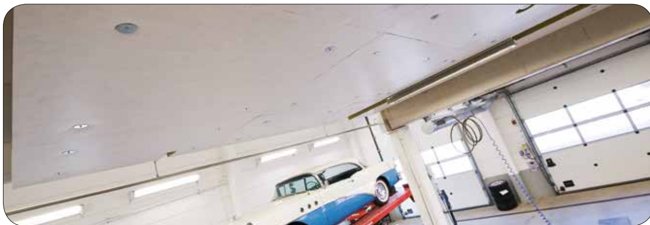
Bullerskivor med glasfiberfilt skruvas fast i vägg eller tak med fästdon för betong, lättbetong, plåt eller trä.
